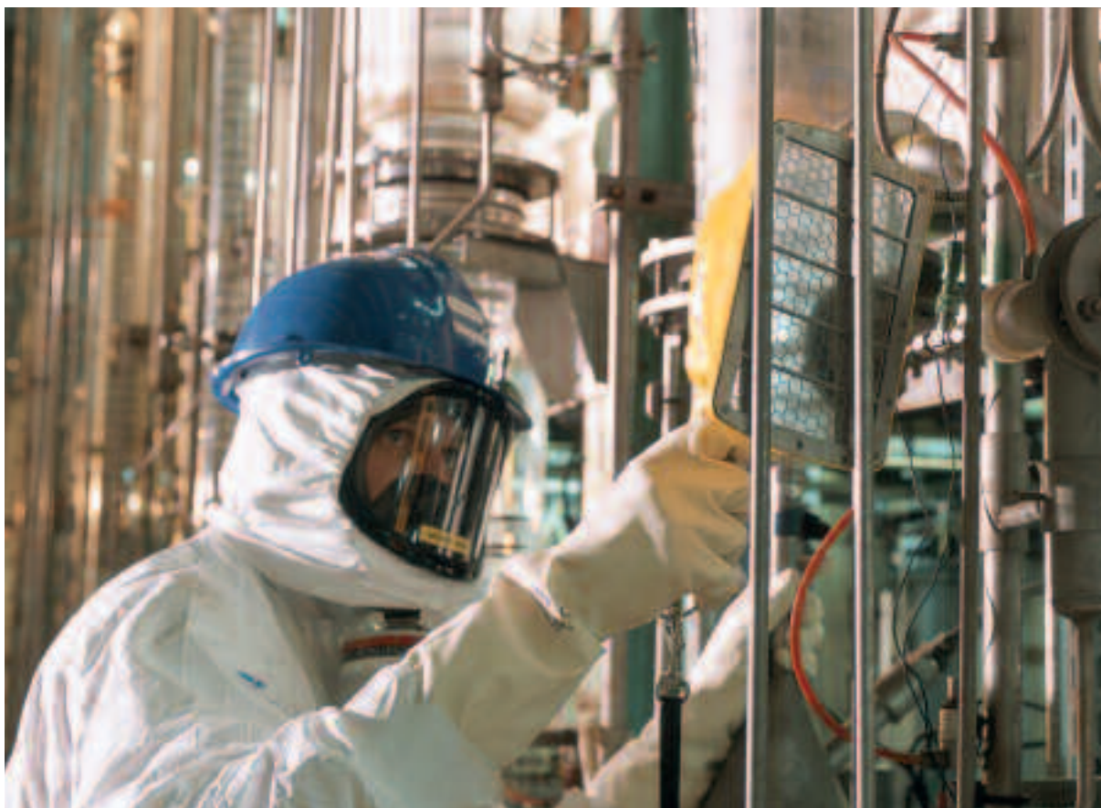
Contrôle radiologique de l'extérieur des colonnes pulsées, après assainissement et avant démontage dans le bâtiment 91 de l'INB 57. Chantier de démantèlement assuré par la société SOGEDEC, site de Fontenay-aux-Roses
