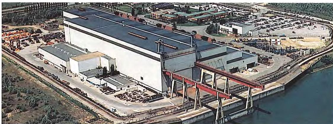
L'usine Framatome de Chalon/Saint-Marcel est dédiée depuis sa mise en service en 1975 à la construction de composants majeurs du circuit primaire principal des chaudières nucléaires à eau sous pression. Il s'agit de la cuve du réacteur, des générateurs de vapeur et des pressuriseurs. Cette fabrication a requis à ses débuts la mise en œuvre des principales compétences suivantes :
