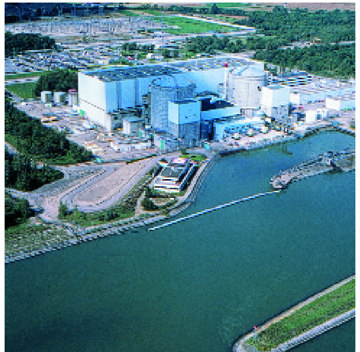
Centrale de Fessenheim
