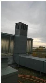
Le circuit de ventilation du secteur chaud est indépendant de l'ensemble du système de ventilation du reste du bâtiment. Le rejet s'effectue sur la terrasse niveau 4 et l'air extrait ne fait pas l'objet d'un recyclage, distant de toutes prises d'air neuf (Cf photo ci-contre).
