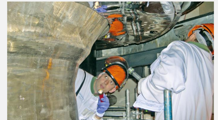
Contrôles réalisés par l'ASN lors d'une épreuve hydraulique
