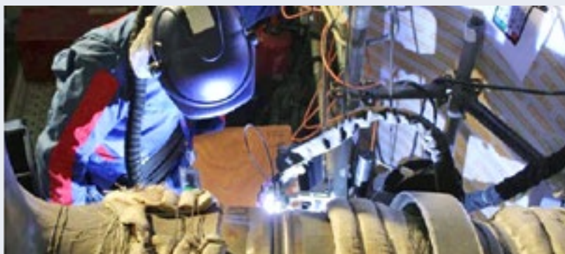
Mise en œuvre du procédé TIG orbital – soudure sur le circuit secondaire principal
