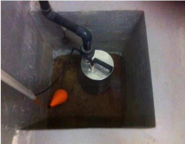
Le local forme un bac de rétention étanche, de la capacité des 3 cuves, équipé d'un puisard, contenant un détecteur de fuite et une pompe de relevage.
