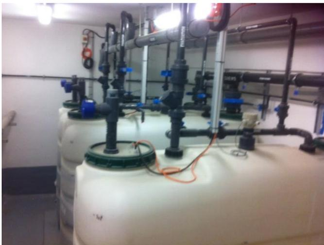
L'installation consiste en 3 cuves de marque Sotralentz, de 3000 litres environ en polyéthylène haute densité (PEHD) de couleur blanche, sans sortie basse, de dimension Longueur x Largeur x Hauteur 2470 x 880 x 1790 mm
