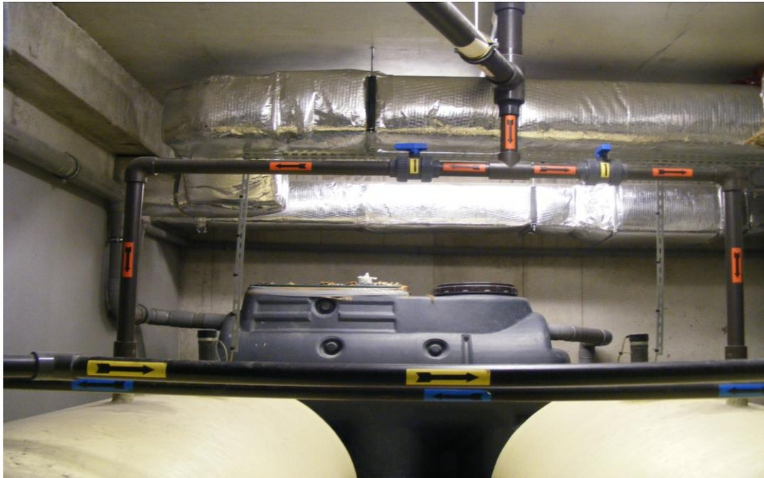
**Cuves de décroissance, fosse de rétention, vannes d'ouverture et de fermeture des cuves**
