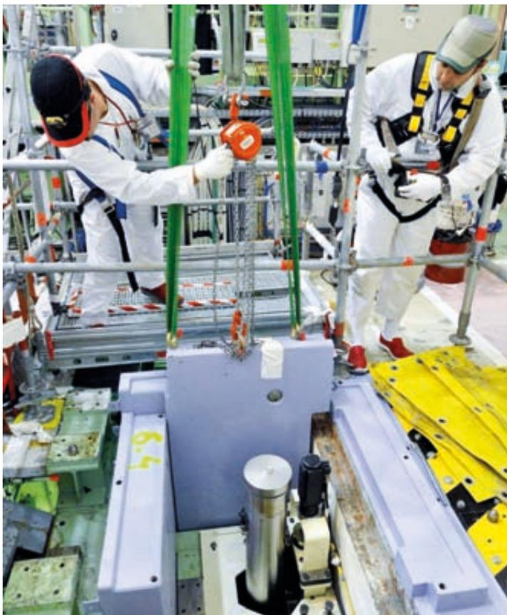
Mise en place d'une protection biologique dans l'enceinte du réacteur de recherche Cabri, 2012.
