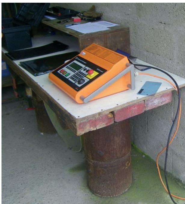
Pupitre de commande d'une installation fixe non autorisée et non conforme en radiographie industrielle – Avril 2011
