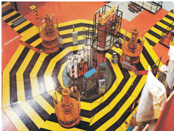
PHÉNIX reactor platform in Marcoule (Gard département)
