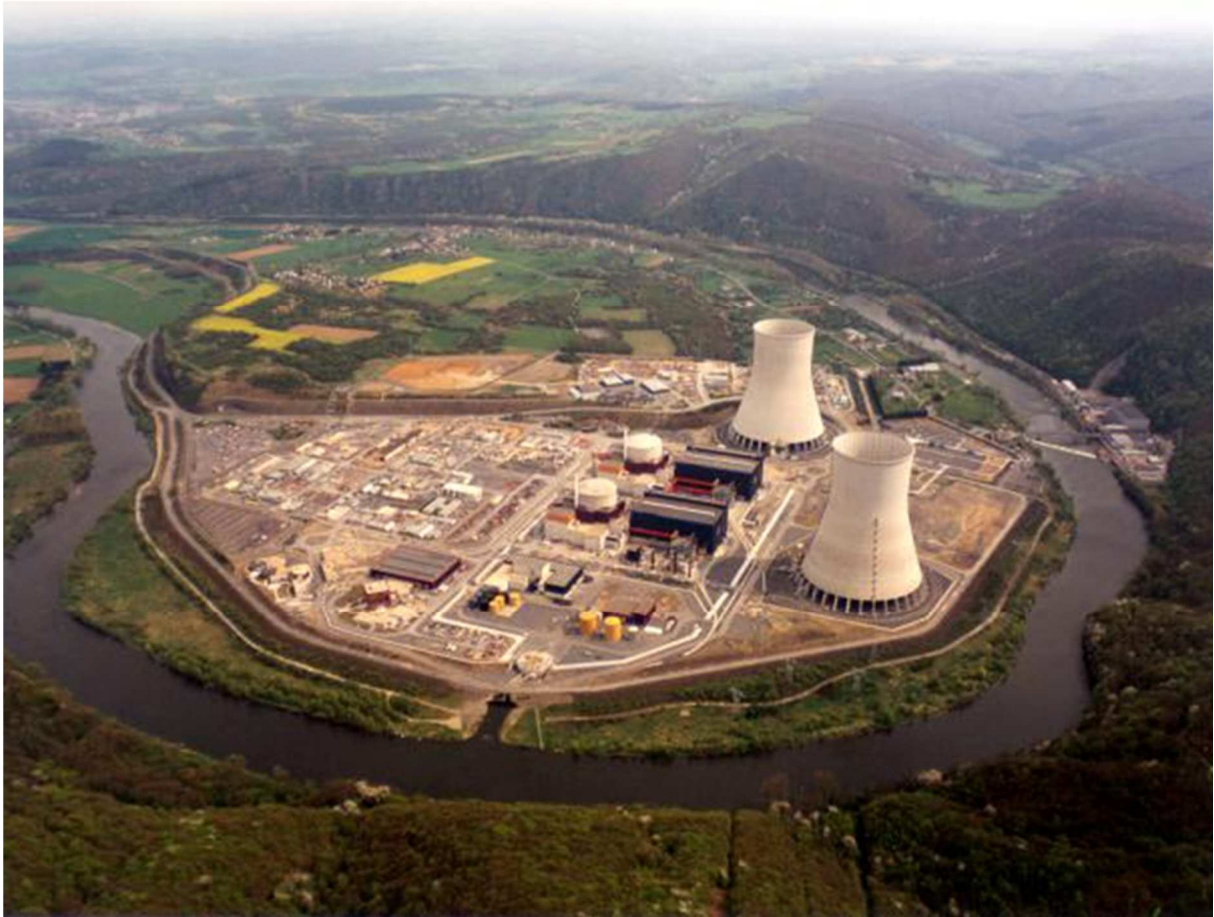
Photographie aérienne du site électronucléaire de Chooz
