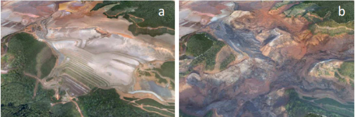
Figure 5. Site de la digue Fundão et du réservoir a) avant et b) après rupture
