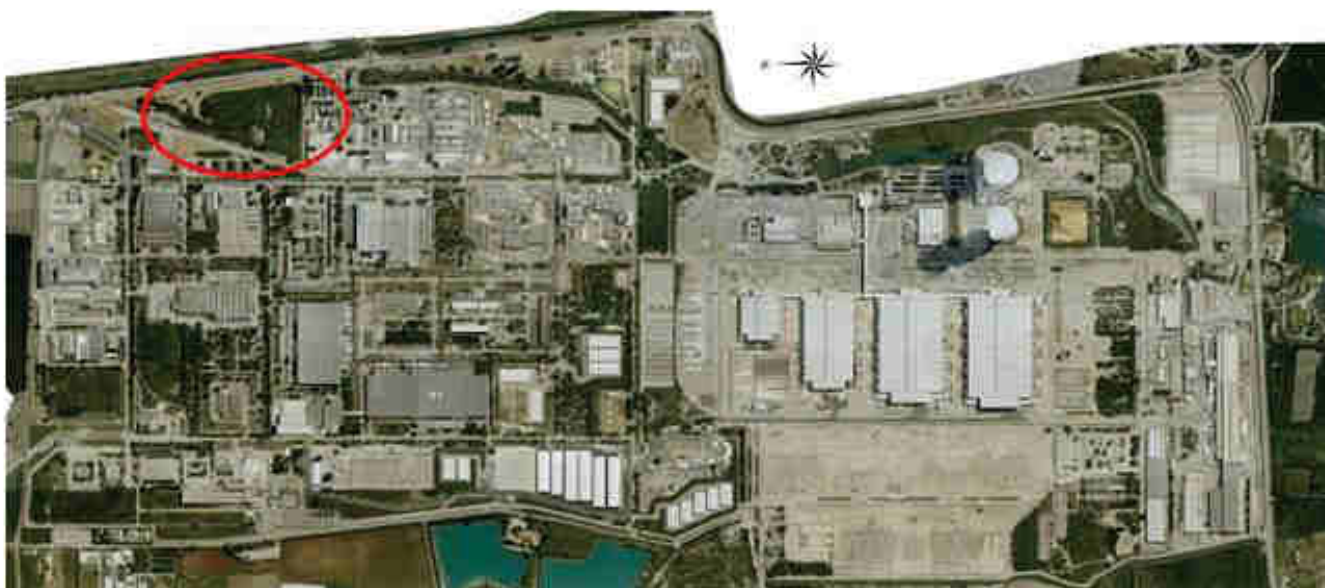
Figure 1 : Implantation de la butte sur le site du Tricastin
