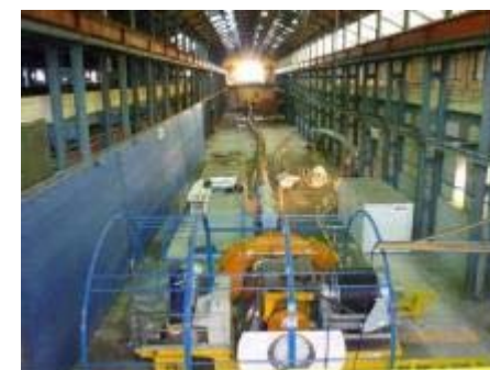
Mise en place colis HA
