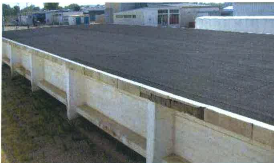
Figure : Vue de la toiture : Le revêtement bitumineux étanche de la toiture est en très bon état
