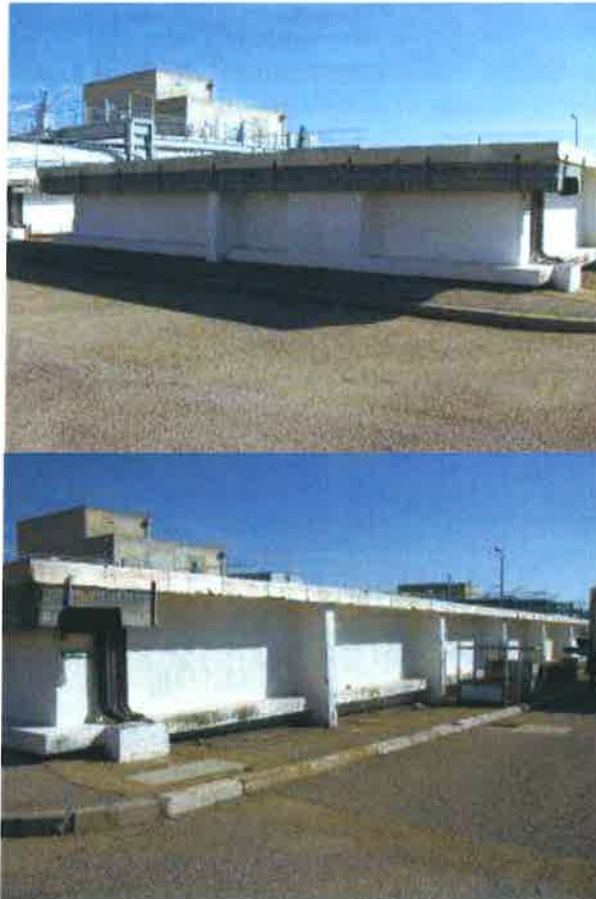
Figures : Vues d'ensemble du « pilote Dégainage »
