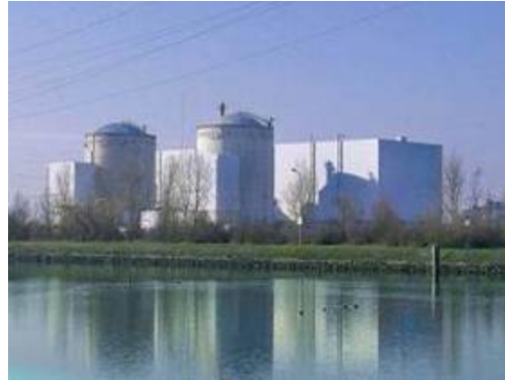
La centrale nucléaire de Fessenheim
