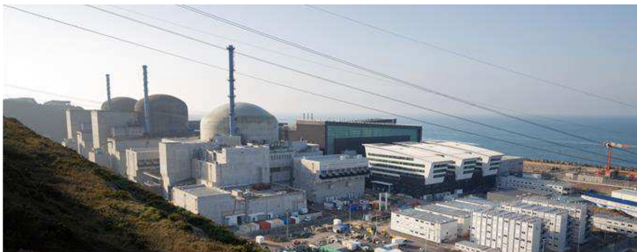
Figure 2.u : Cheminées des trois bâtiments des auxiliaires nucléaires
