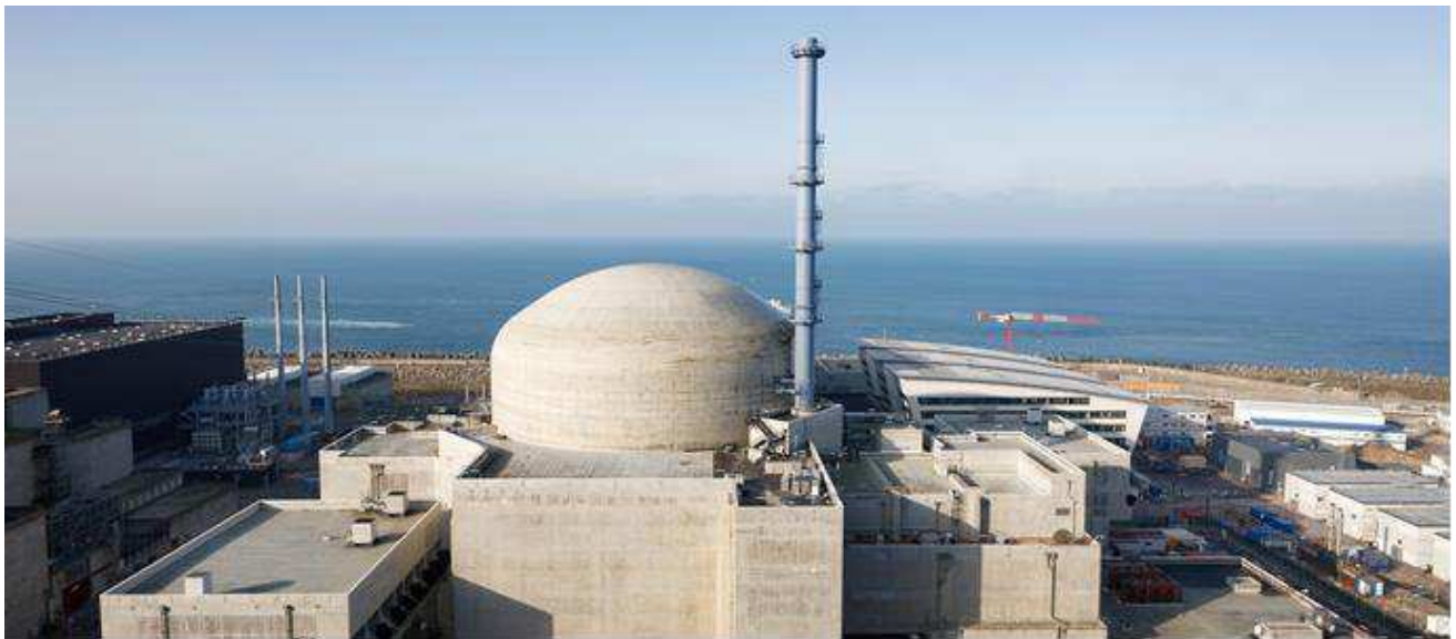
Figure 2.v : Cheminée du bâtiment des auxiliaires nucléaires (HN) du réacteur 3
