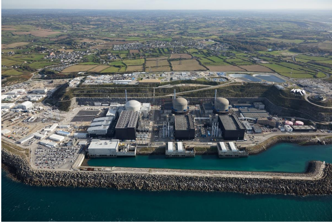
Figure 4.b : Vue aérienne du site de Flamanville ©EDF
