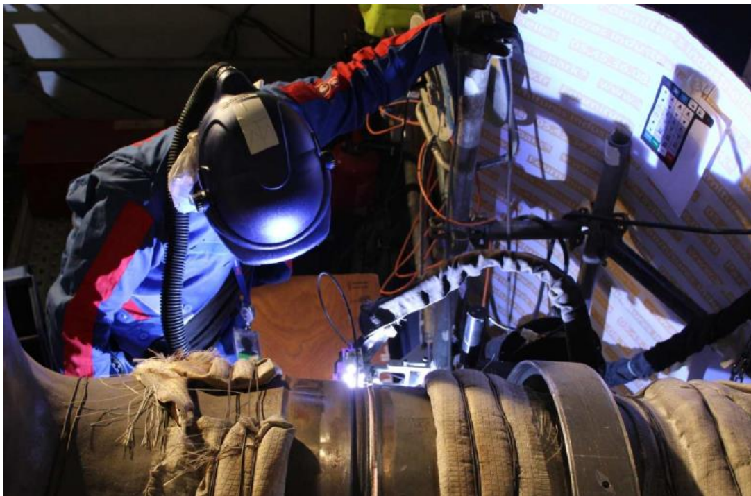
Figure 56 : Mise en œuvre du procédé TIG orbital (extrait site internet EDF)
