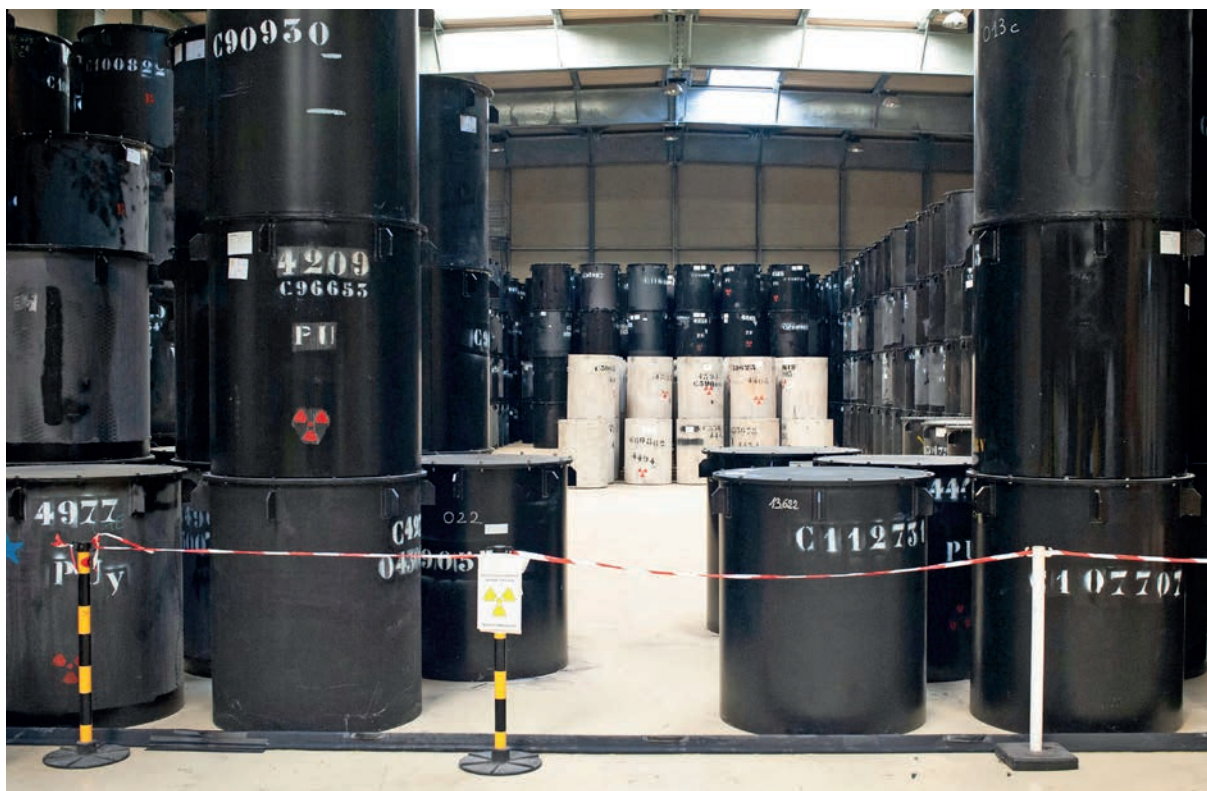
Installation Cedra du CEA de Cadarache
