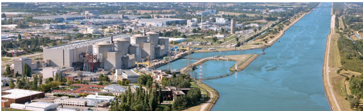
Centrale nucléaire du Tricastin
