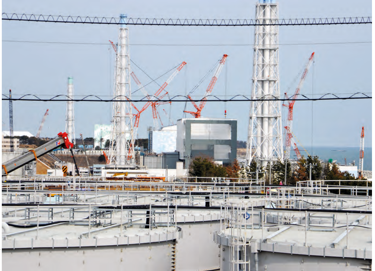
La centrale de Fukushima Daiichi, février 2015.
