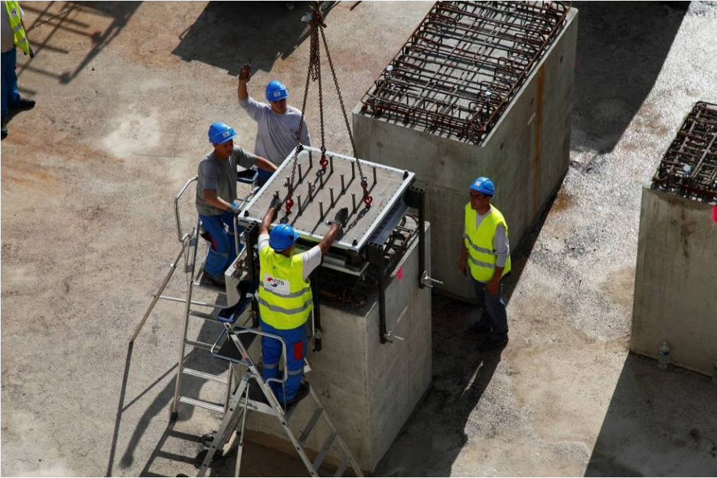
Mise en place d'un appui parasismique
